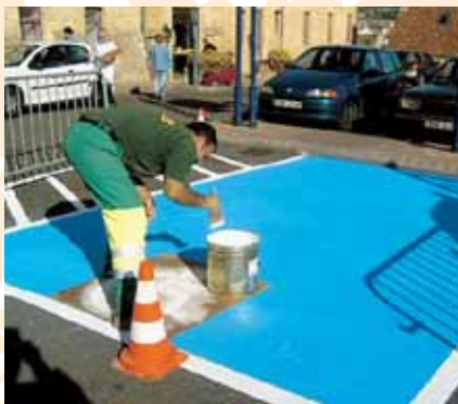
CENTRE-VILLE. AMÉNAGEMENT D'EMPLACEMENT POUR LES PERSONNES À MOBILITÉ RÉDUITE.
