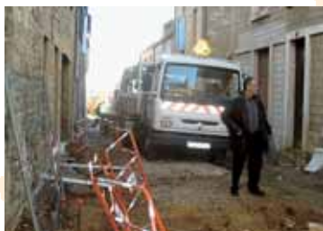
RUE JEAN-JOSEPH CALES. VERS UNE RÉHABILITATION DE CETTE ARTÈRE.
