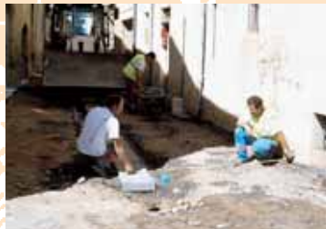
RUE BARAYRON. LES TRAVAUX SONT À PRÉSENTS TERMINÉS.
